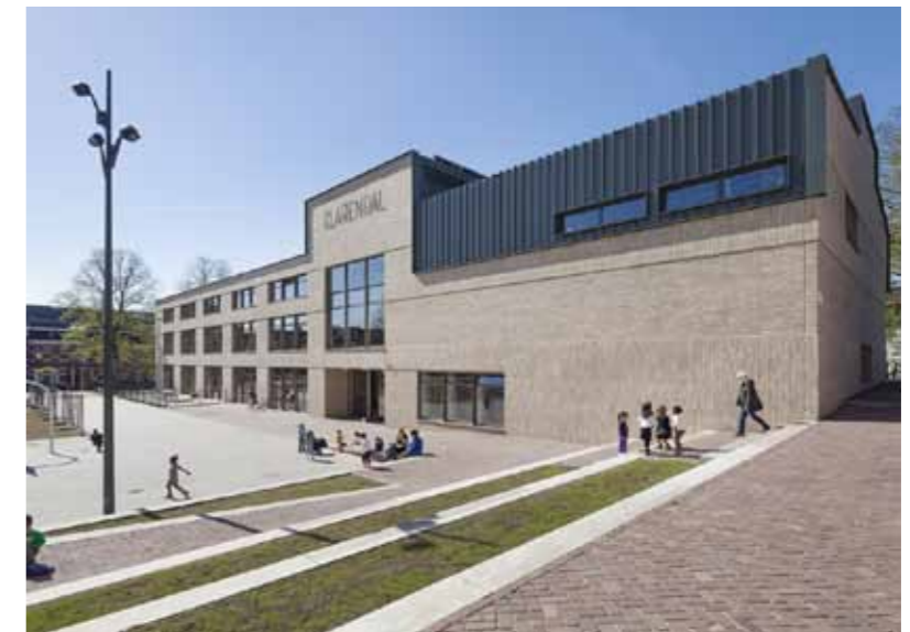
Referentiebeeld moderne architectuur, heldere hoofdvormen en terughoudend kleur- en materiaalgebruik
