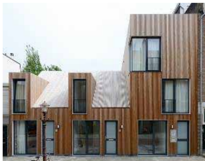
Geschakelde bebouwing met geleiding in gevelvlak en daklijn aan de Parklaan
